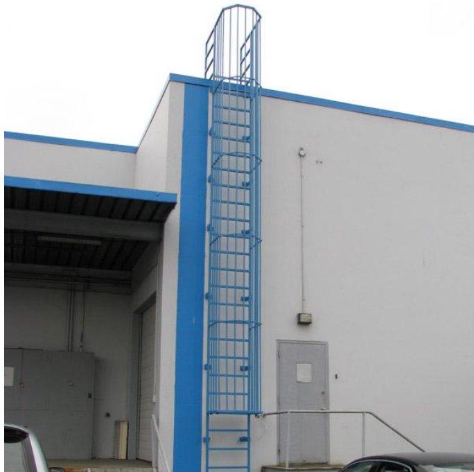
Hình. Lối thoát khẩn cấp với CẦU THANG NGOÀI TRỜI để bạn trèo lên mái nhà tránh sóng thần (hình minh họa) 15 Bạn có thể làm một chiếc thang đơn giản hơn.
