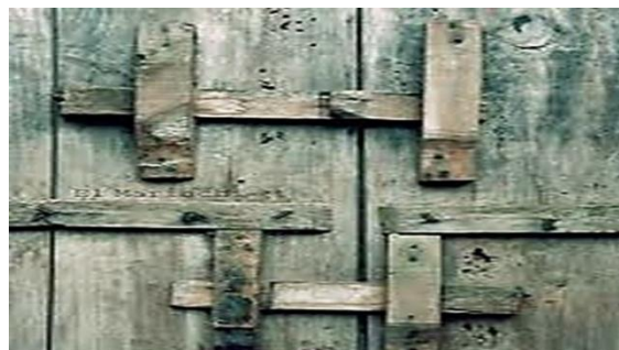
Hình (minh họa). Một chốt cửa đơn giản 13 để khóa cửa thoát hiểm khẩn cấp từ phía bên trong nhà bạn
